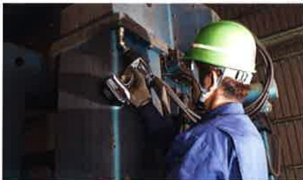
設備のメンテナンス作業に
